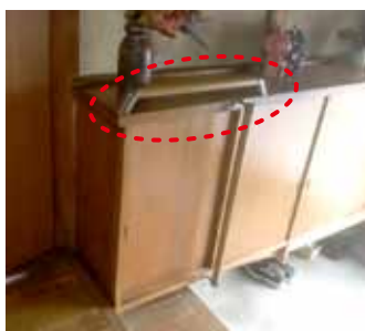
※施工イメージ
